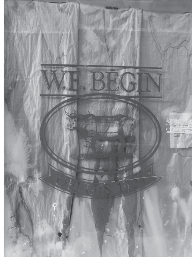
C'est le financement qui bloque les travaux sur la rue Saint-Jean à apprès L'Infobourg . Le propriétaire espère tout démolir au printemps pour finalement rouvrir à l'été 2014. Photo : Marie-Raphaëlle LeBlond
