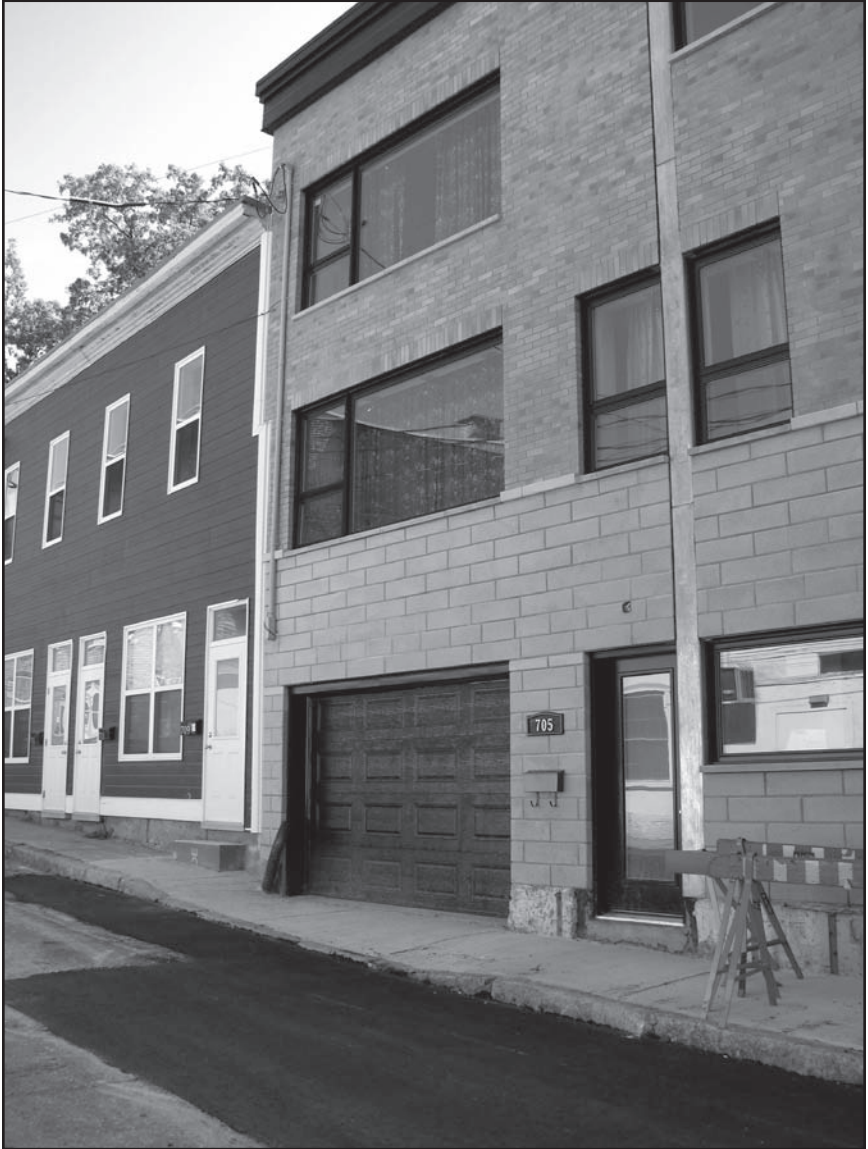
Exemple de rez-de-chaussée transformé en garage. Photo : Marc Boutin
