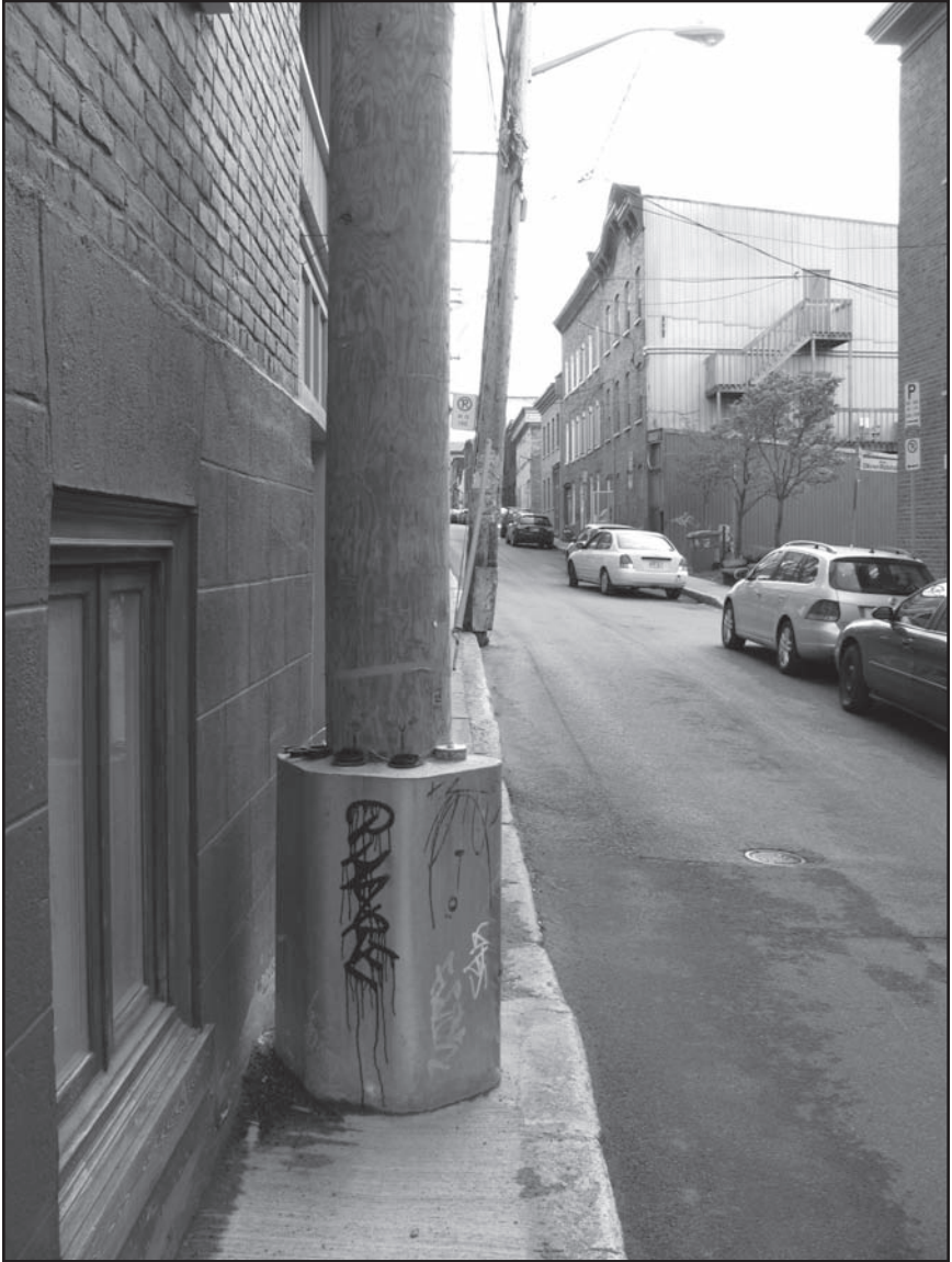
Poteau récemment installé sur la rue La Tourelle, qui nuit au passage des piétons et les incitent à utiliser la chaussée. Photo : Marc Boutin
