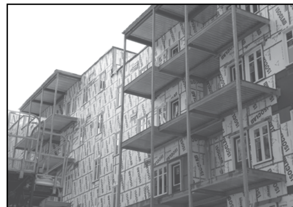
Si on se fie au dernier budget, les chantiers de construction de nouvelles coopératives d'habitation, ici l'Escalier sur l'Îlot Berthelot, se feront plus rare dans les prochaines années. Photo: archives Infobourg
