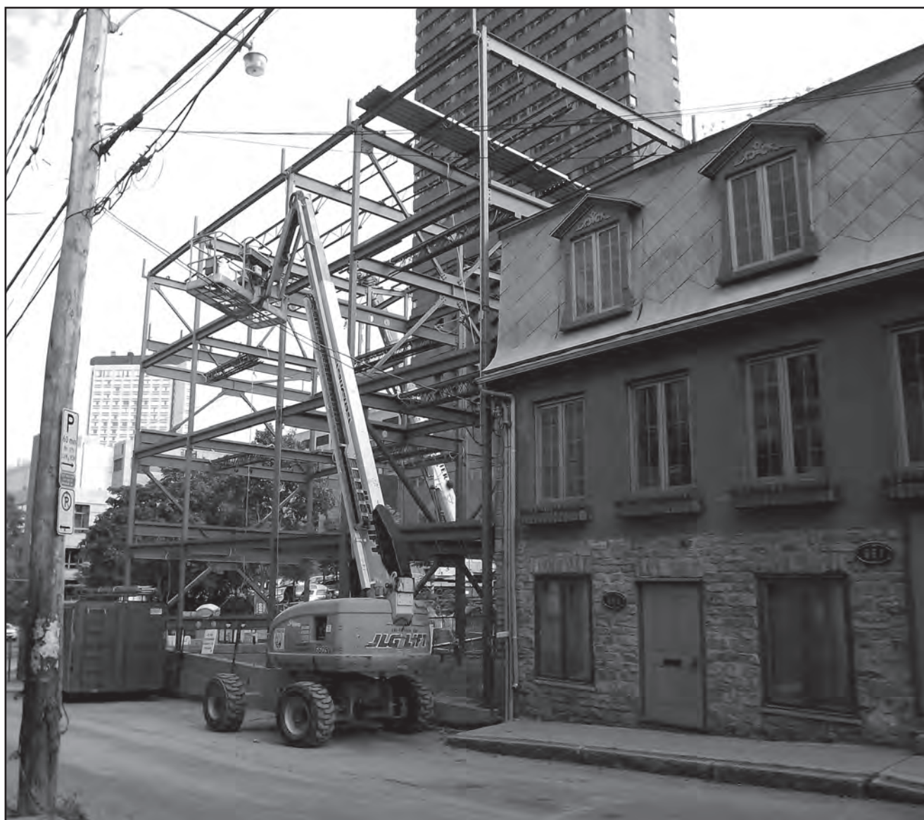
Le chantier vu de la rue Saint-Gabriel tel qu'il se présentait le 21 septembre.
